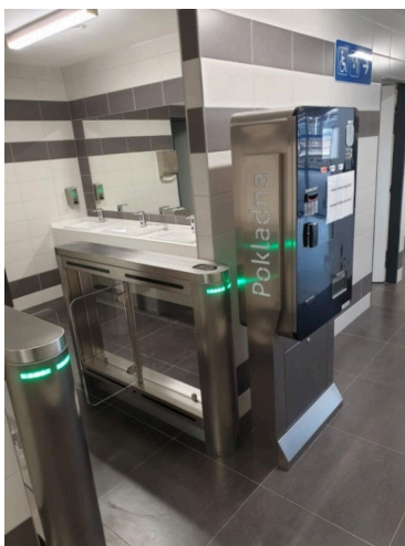
Obrázek B.1 - Turniket - dvoukřídle provedení (Speed Gate)
